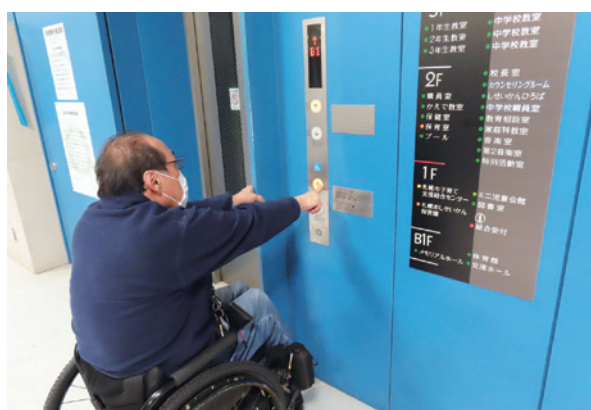
エレベーターを完備。各階には多目的トイレも
